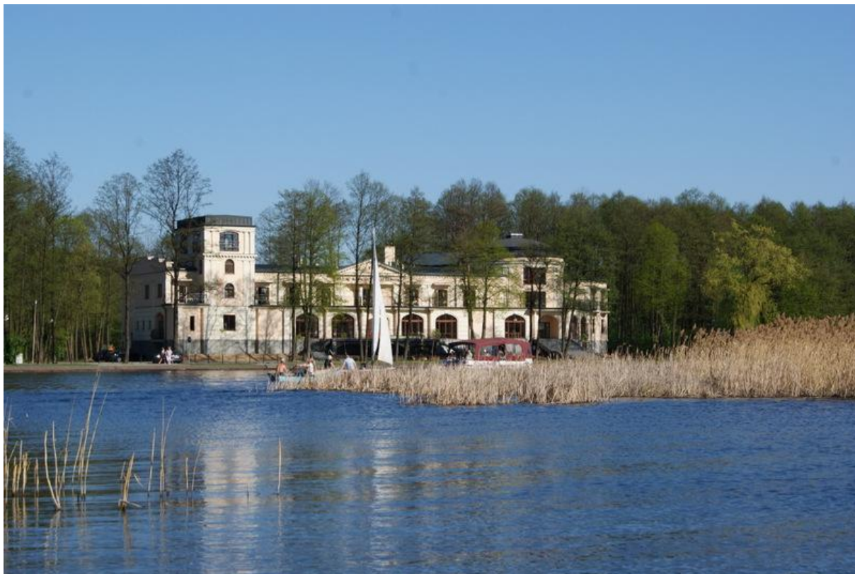
Ryc. Budynek „Pałacu na wodzie” z zewnątrz
