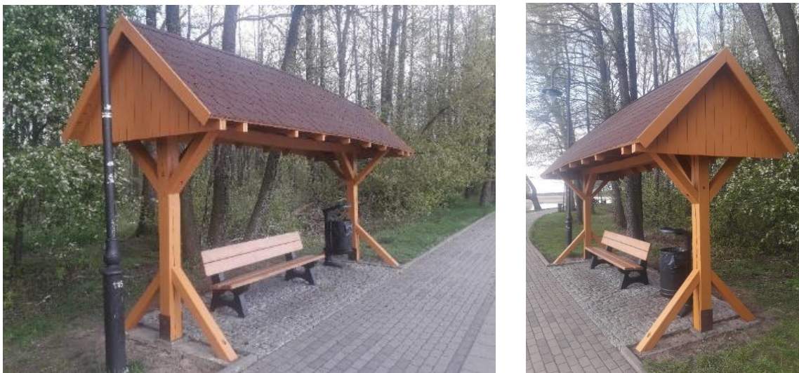
Fot. 19. Modernizacja wiat
