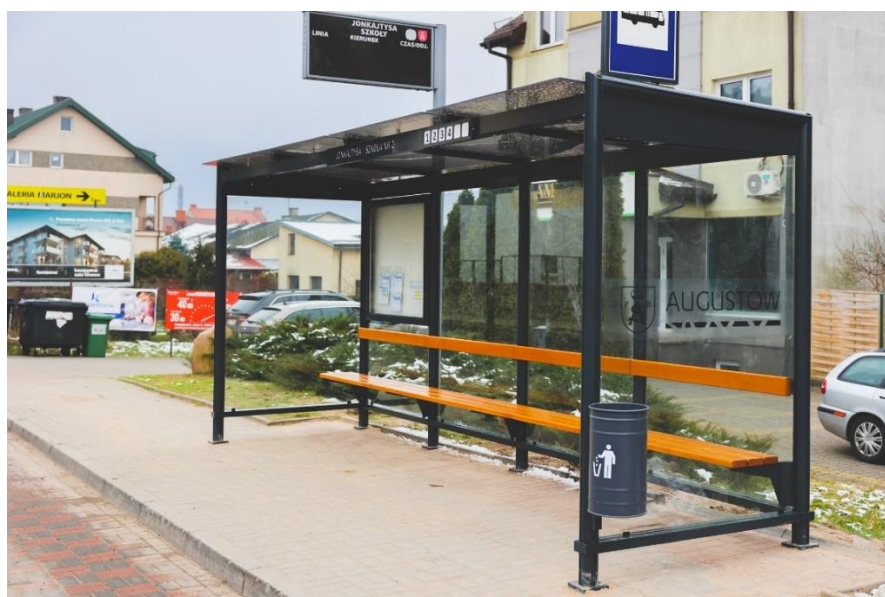
Fot. 24. Wiata przystankowa
