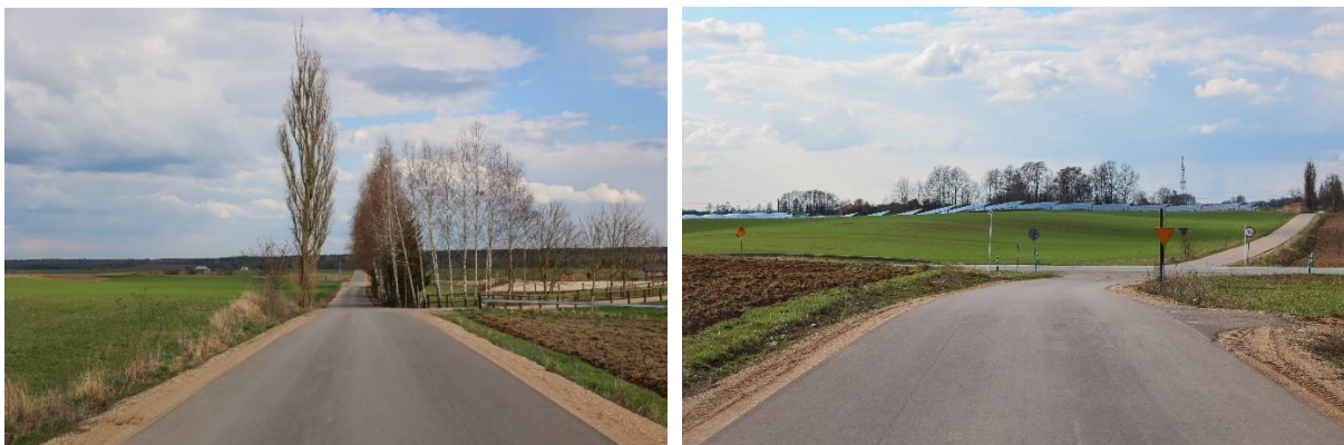
Przebudowa drogi gminnej nr 102636B Żarnowo II – Białostrzegi od km 0+000 do km 0+990,40
